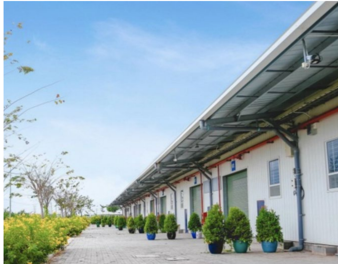
NHÀ XƯỞNG KIZUNA 3 - LONG AN
